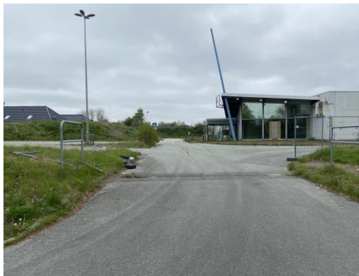
Abbildung 16: Blick aus das NVZ Tondernsche Straße aus südlicher Richtung
