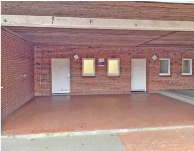
Hofeingang mit zur Schulhofseite orientierter WC-Anlage. In der Konzeptstudie wird vorgeschlagen, diesen Bereich baulich zu integrieren, sodass die WCs künftig über den Innenraum erreichbar sind.
