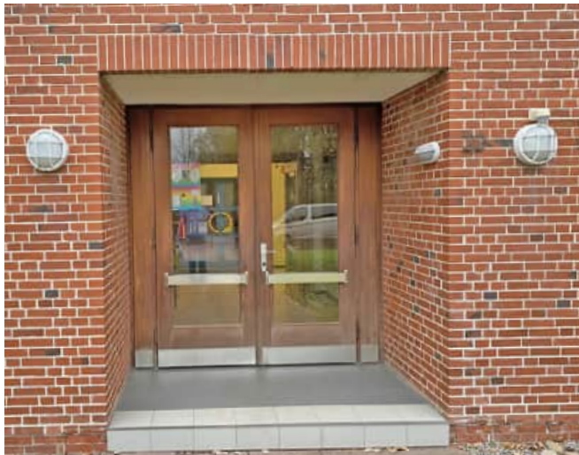
Nebeneingang mit bauzeitlicher Türanlage.
