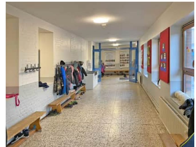
Erschließungsflur im Erdgeschoss – dieser Bereich war ursprünglich ein überdachter Außenraum
