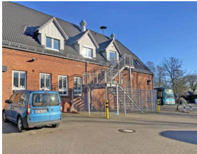
Neue Fluchttreppe von 2024, welche die Nutzung des Dachgeschosses ermöglicht
