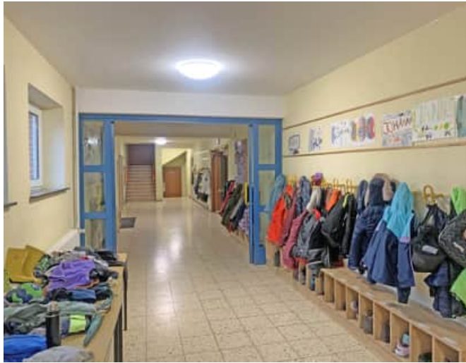
Garderoben- und Wechselbereich im Erdgeschossflur. Laut aktuellem Brandschutznachweis müssen die Garderoben aus den Fluren entfernt werden.
