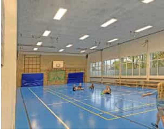
Die Sporthalle in Drelsdorf gehört zu den am stärksten ausgelasteten Hallen im Schulverband. Der Boden und die Beleuchtung wurden erst vor Kurzem erneuert.
