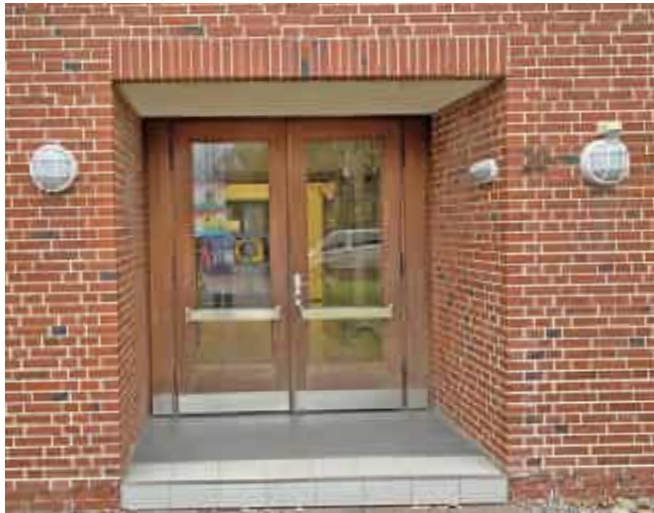
Nebeneingang mit bauzeitlicher Türanlage.
