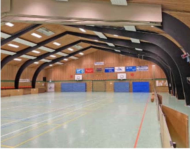
Die Zweifelhalle aus den 1970er Jahren mit markenten Dreigelenkbögen aus Holz.
