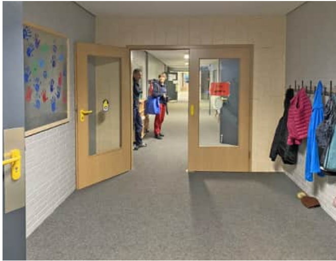
Flurbereich im Klassentrakt. Die Tür wurde eingebaut, um die Schallausbreitung im Flur zu reduzieren. Die Raumakustik müsste verbessert werden.
