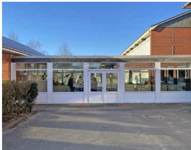
Die Pausenhalle verbindet die drei Gebäudeteile der Schule. Im Hintergrund ist der Sonnenschutz des Klassentraktes der 70er Jahre zu sehen. Er bewirkt eine starke Verdunkelung der Klassenräume.
