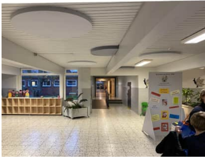
Eingangsbereich der Pausenhalle mit Ranzenregal. Die Deckenabsorber verbessern die Raumakustik leicht, doch die Halle benötigt deutlich mehr raumakustische Maßnahmen.
