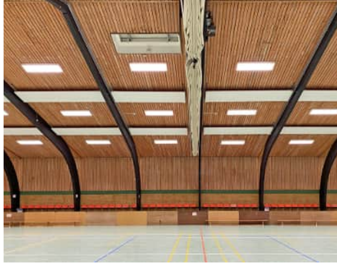
Die Halle wird künstlich belichtet und belüftet. Die Dachöffnungen dienen allein dem RWA.
