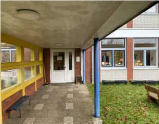
Überdachte und teilweise verglaste Verbindungswege.
