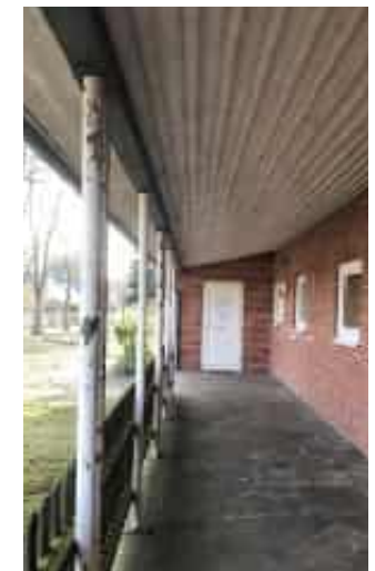
Außenliegender Laubengang des Südflügels.
