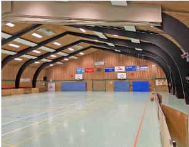
Die Zweifeldhalle aus den 1970er Jahren mit markanten Dreigelenkbögen aus Holz.
