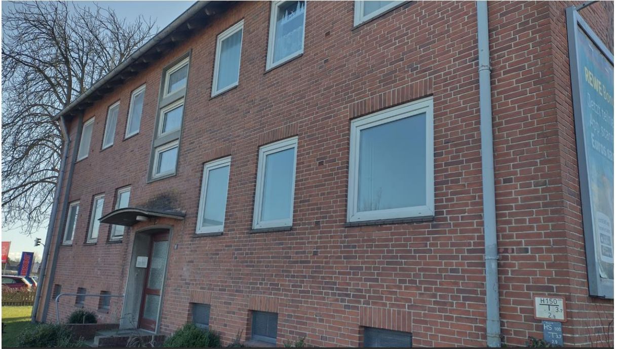
Einziges Mehrgeschossgebäude, keine Nester von außen erkennbar.
