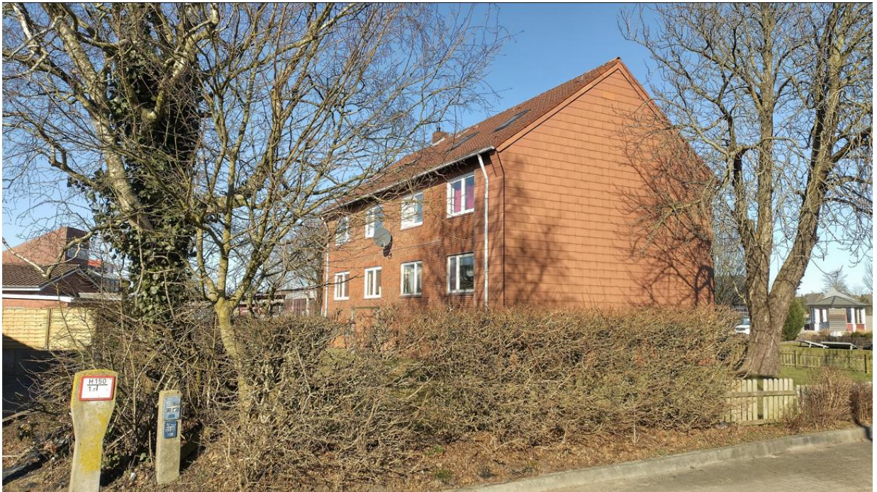
Altbaum (Kastanie) im Nordosten, im Bild rechts, ist zum Erhalt festgesetzt. Gebäude ohne Potenzial für Vögel/Fledermäuse.
