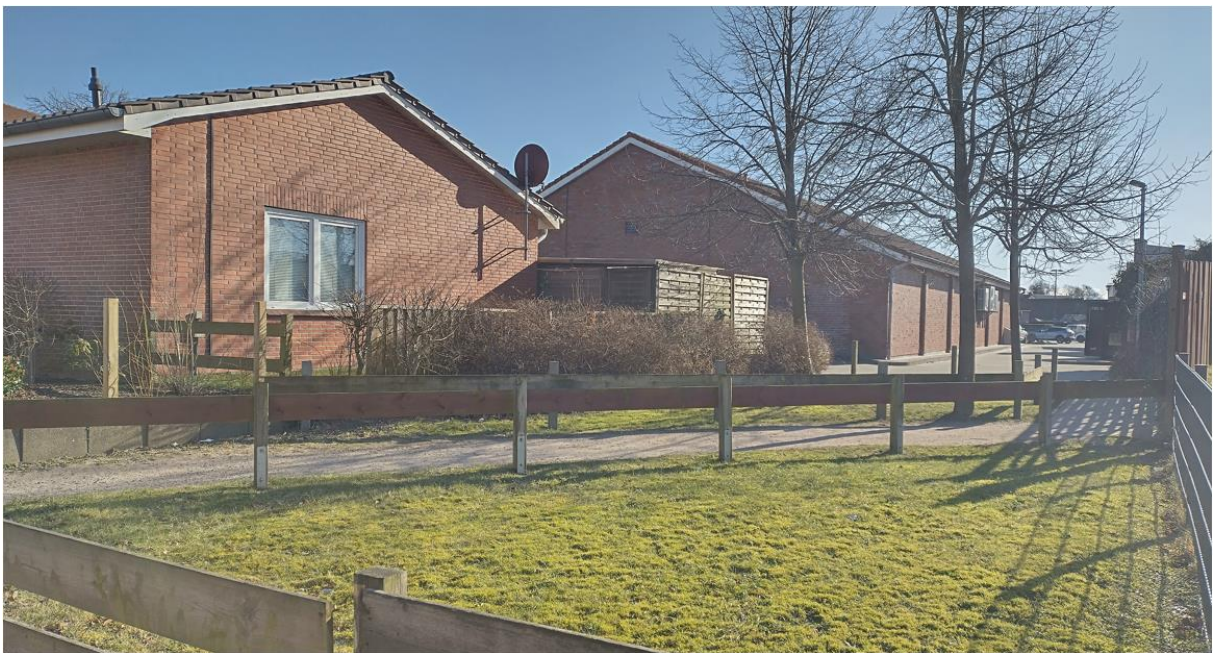
Durchgang zum Supermarkt und Gebäude im Nordosten.
